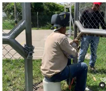
Reparaciones menores de soldadura. Barrio La Herradura
